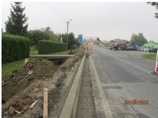
Inwestycja w trakcie realizacji
