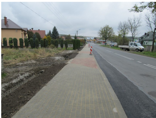
Inwestycja po realizacji
