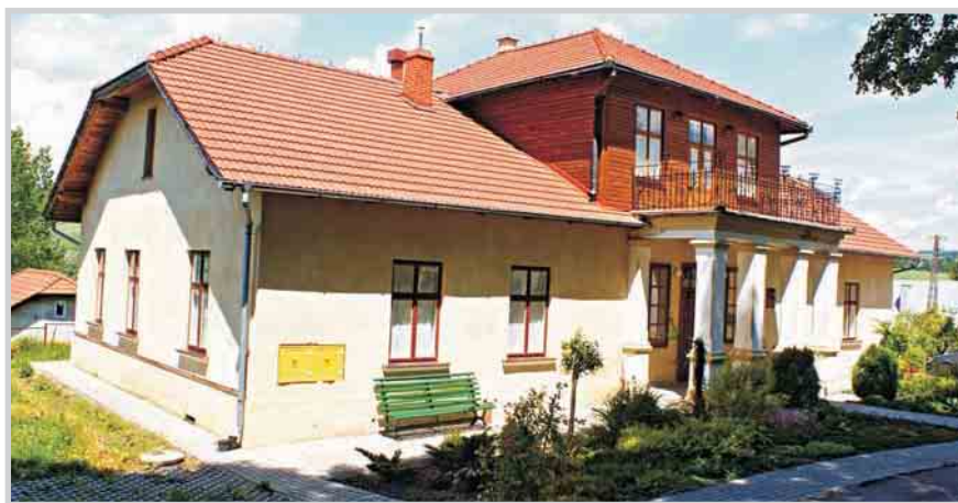
▲ Remont starej plebanii rozpoczął się w 2000 r. z inicjatywy powołanego rok wcześniej Towarzystwa Przyjaciół Ziemi Wielopolskiej im. Tadeusza Kantora.
